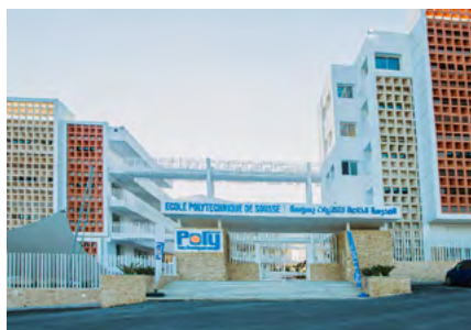
Ecole polytechnique de Sousse (7800 m 2 Dalle Alvéolée)
