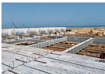
Station désselement eau de mer Gabes (dalle alvéolée et Dalot)
