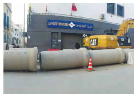
Rénovation réseau pluvial la Goulette (Tuyaux)
